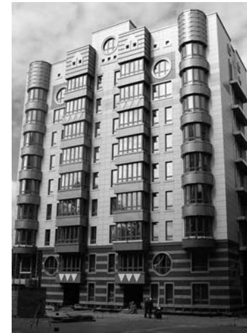
Дом по ул. Институтской 9-А в Киеве
